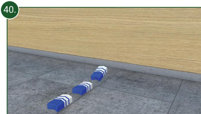
40. Das Prinzip der Hinterlüftung wird nun durch den Lufteintritt an der Unterseite der Fassade...
