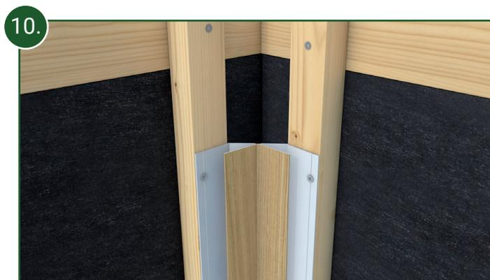
10. Das variable Eckprofil wird mittels Schrauben entlang der eingebrachten Schraubnuten im Abstand von 40 cm mit den Traglatten fixiert.
