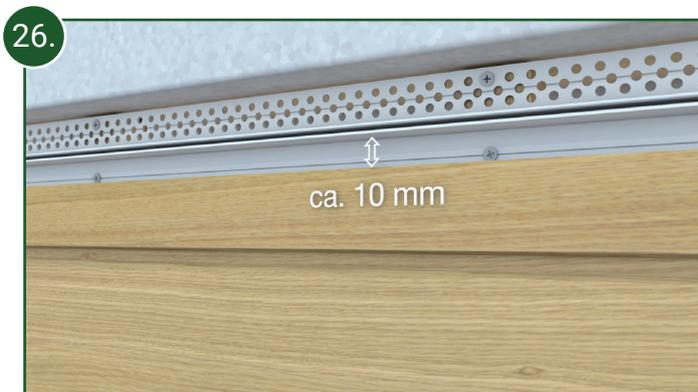
26. Der Abstand der Sägekante zur Klipsnut des oberen Lüftungsprofils sollte ca. 10 mm betragen.
