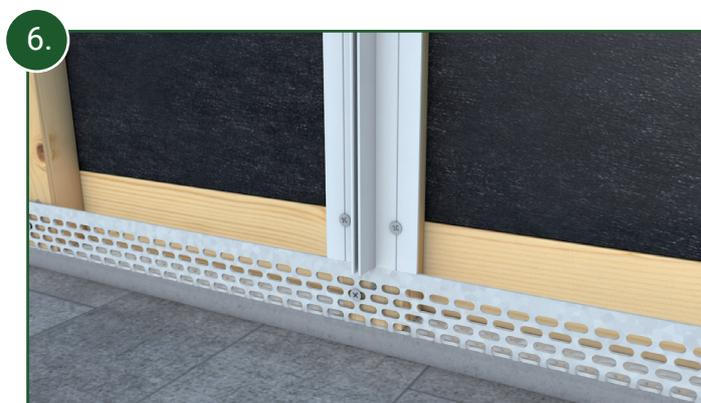
6. Verfahren Sie ebenso mit den Unterteilen der Verbindungsprofile, wenn ein längsseitiger Stoß der Fassadenprofile erforderlich ist. Die Positionierung der Verbindungsprofile erfolgt mittig auf den Traglatten. Der Abstand zum oberen Fassadenende muss 60 mm betragen.
