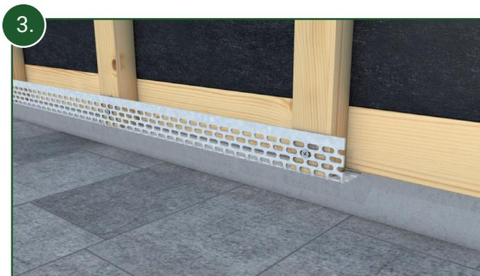
3. Verschrauben Sie das untere Lüftungsprofil 40 x 30 mm entlang des unteren Abschlusses der Fassade mit der Traglattung bis jeweils 40 mm Abstand zu den Außenecken.
