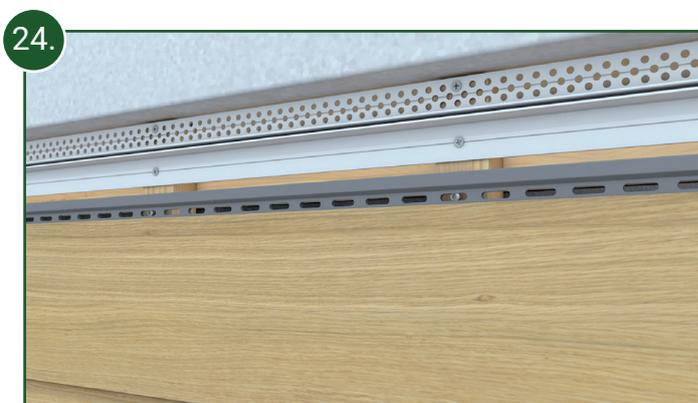
Das letzte Fassadenprofil am oberen Fassadenabschluss muss in den meisten Fällen längsseitig gekürzt werden.
