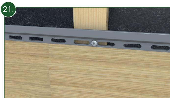
Der Fixpunkt wird gesetzt, indem ausnahmsweise eine Fassadenschraube mittig zwischen zwei Langlöcher gesetzt und fest angezogen wird.
