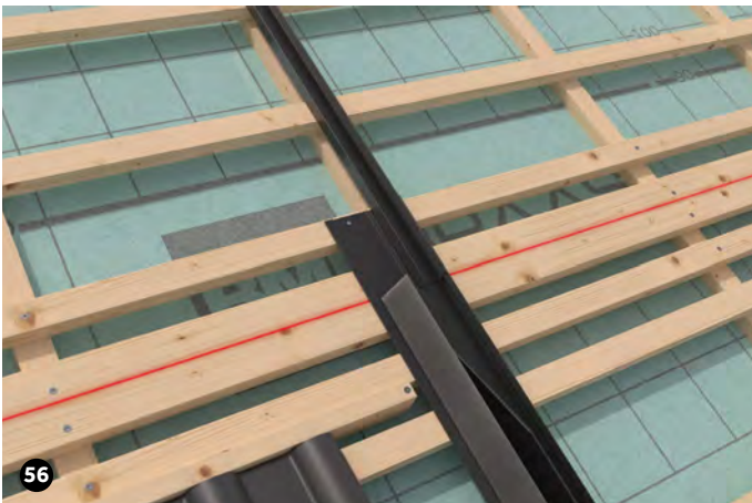
56 In das Seitenteil U eine Drainage-Schiene einschieben. Die Unterkante liegt an der horizontalen Abschnürung auf der Hilfsbohle. Die Drainage-Schiene firstseitig befestigen.
