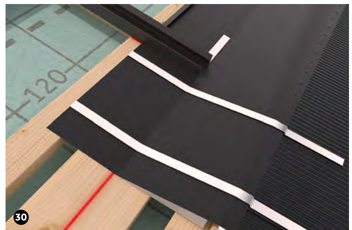
Der Knick der unteren Eindeckbleche liegt auf der horizontalen Abschnürung, die Ausklinkung der oberen Rückkantung entspricht dem Abstand der Module.
