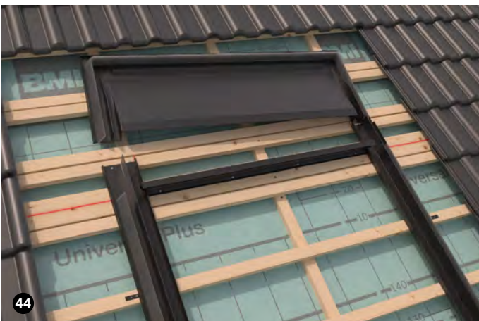
Nach dem Einbau der seitlichen Abdeckbleche und der Firstbefestigung, das obere Eindeckblech einsaltig einsetzen. Der Einbau erfolgt analog zu den oberen Eindeckblechen 6.4.2.
