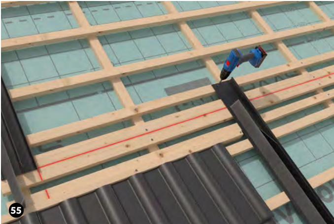
55 Befestigung Seitenteil U auf der Hilfslatte
