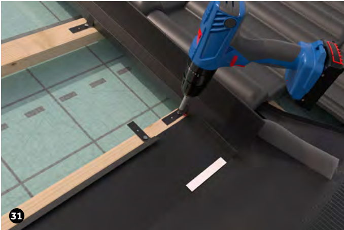
31 Unteres und seitliches Eindeckblech mit beiliegenden Haften befestigen.
