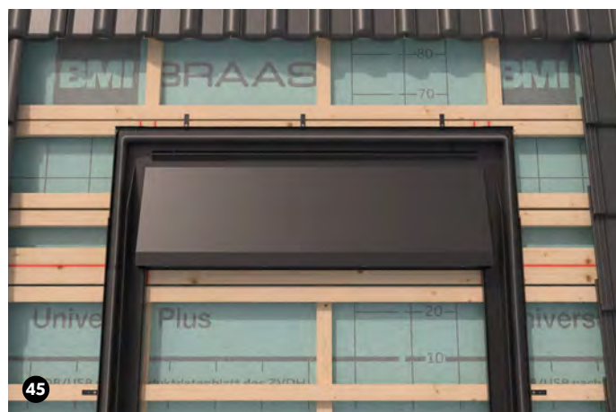
Befestigung mittels Haften.
