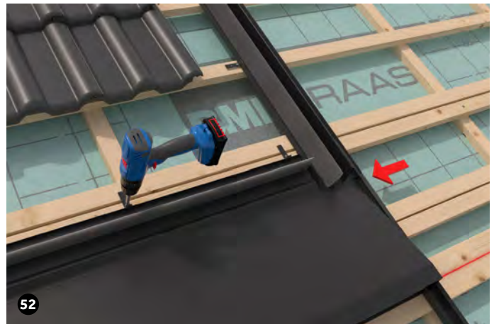
Anbringen und Befestigen mittels Haften des Seitenteils O. Die Unterkante dieses Seitenteils liegt an der Knickkante des Unterteil N.
