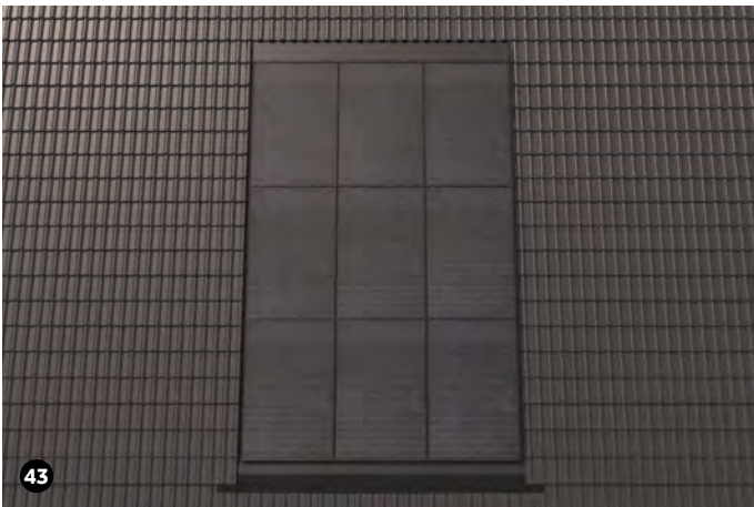
Fertiggestelltes Modulfeld.
