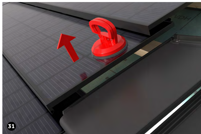
Die Module im oberen Bereich etwas anheben, um die Dachziegel/Dachsteine leichter unter die Module schieben zu können.
